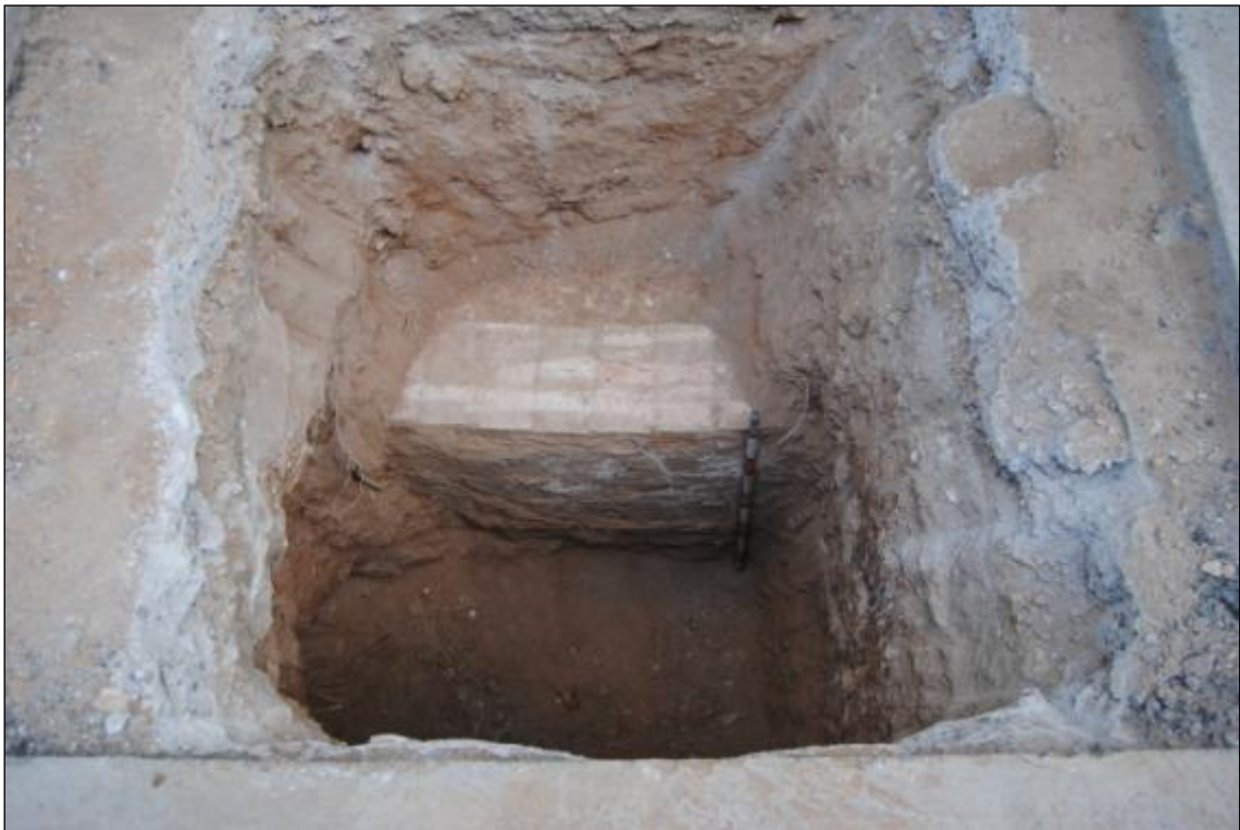
Figura 50. Cala 1. Vista en alçat del col·lector de maons.
