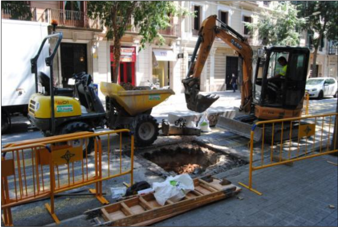
Figura 5. Picat el nivell d'asfalt i ciment/llambordes, es procedeix a buidar la cala amb la pala.
