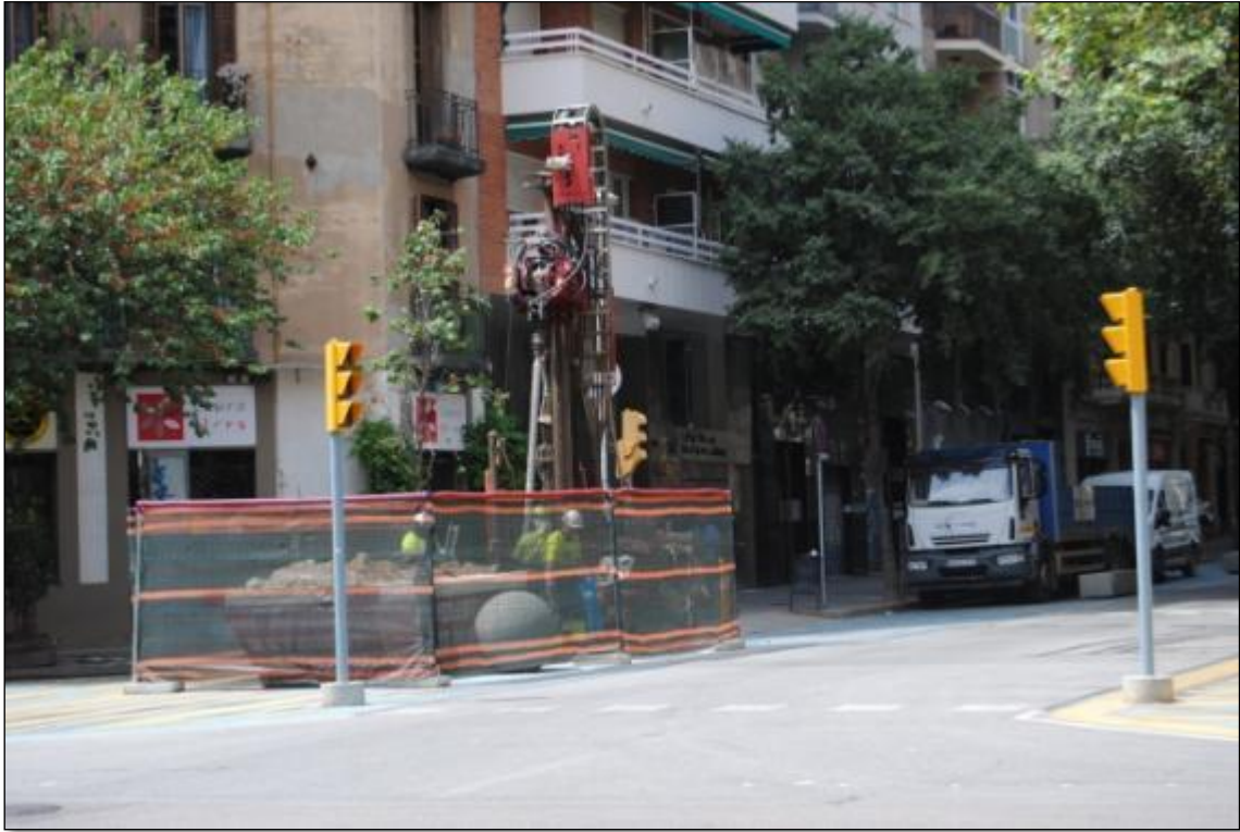
Figura 6. Documentada la cala, els geòlegs passen a realitzar sondejos més profunds per analitzar el sediment.
