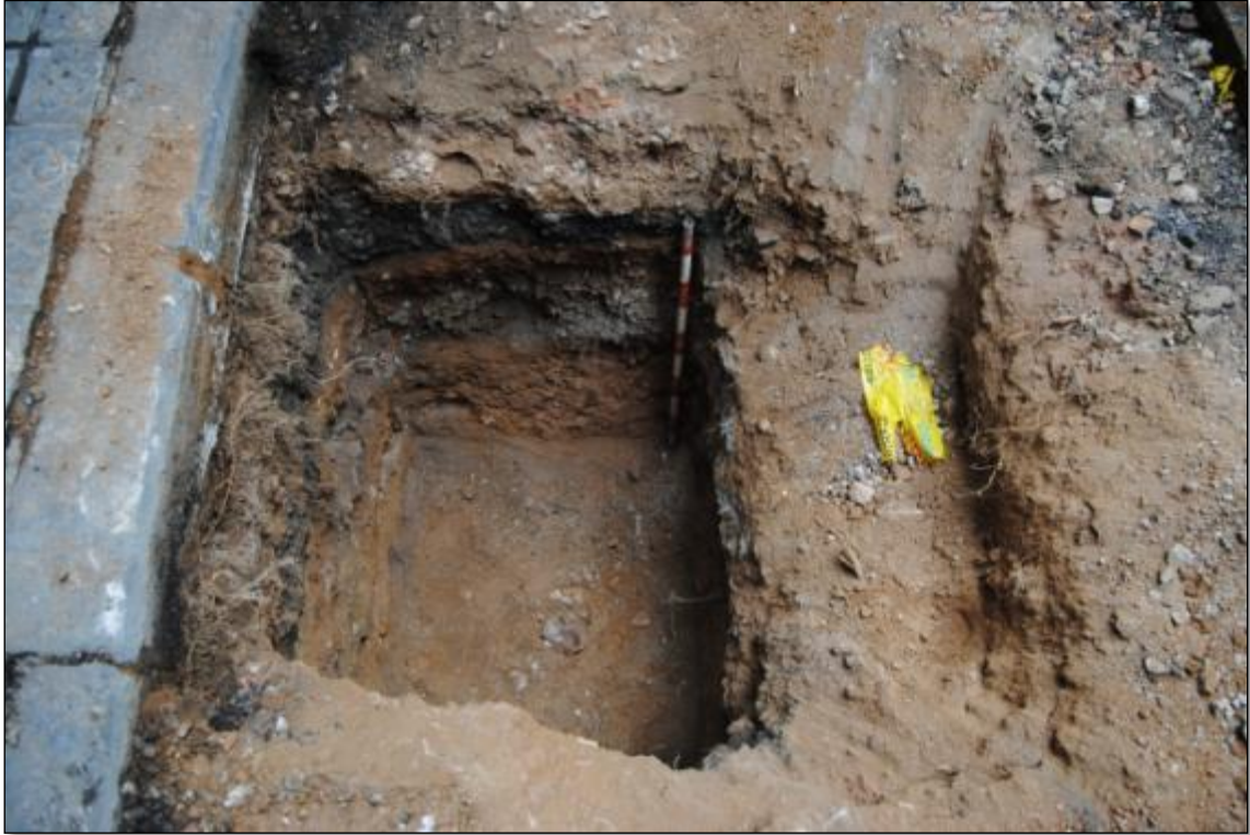
Figura 47. Cala 6. S'observa un servei formigonat de telecomunicacions i estrats heterogenis al costat.
