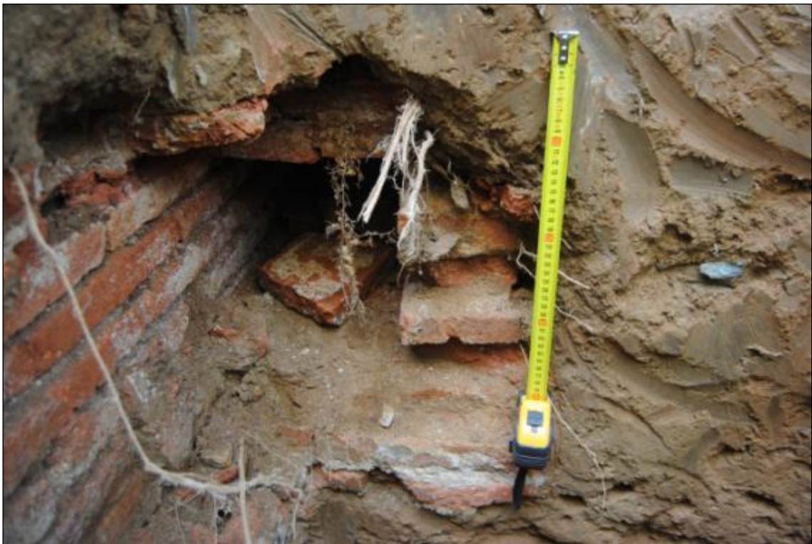
Figura 74. Cala 48. Foto de la secció del conducte.
