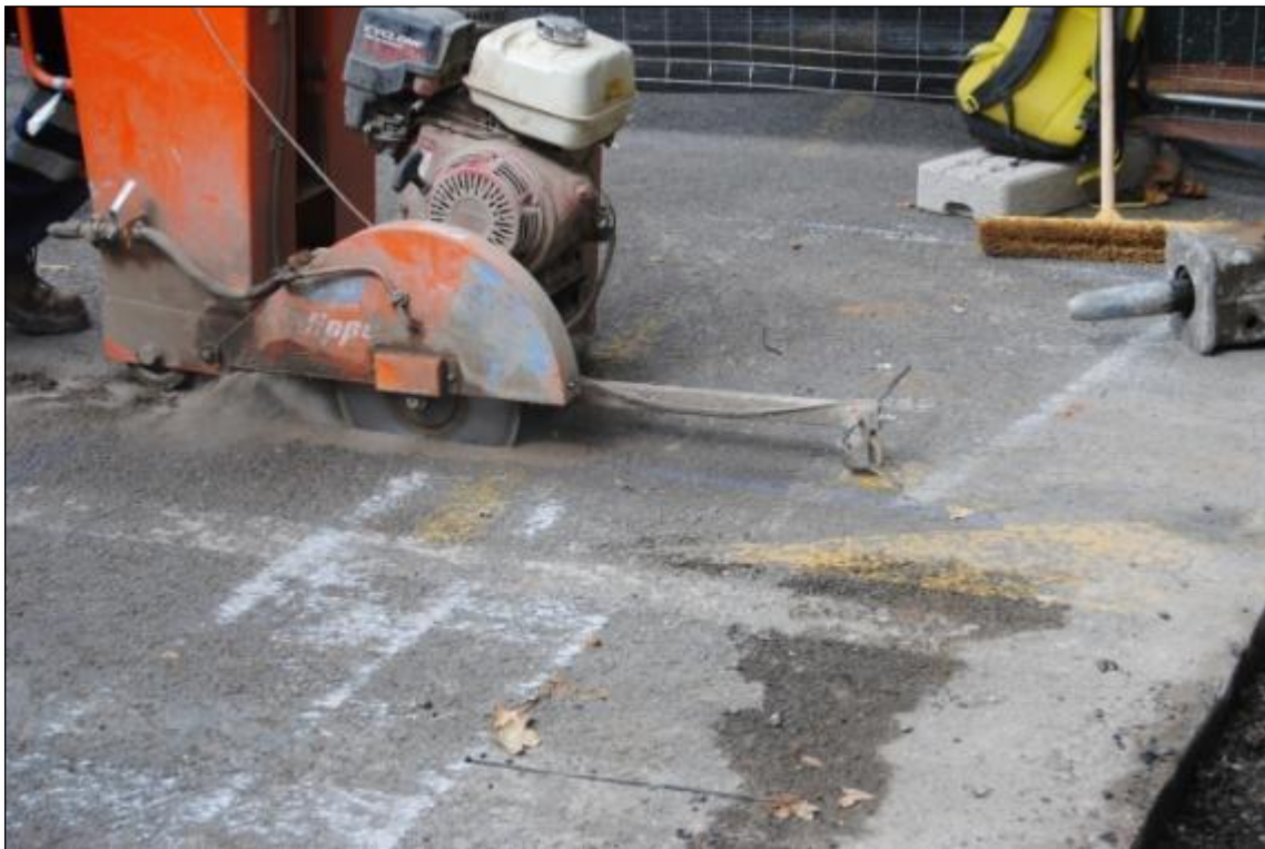
Figura 1. Tall de l'asfalt per delimitar l'àrea a intervenir.
