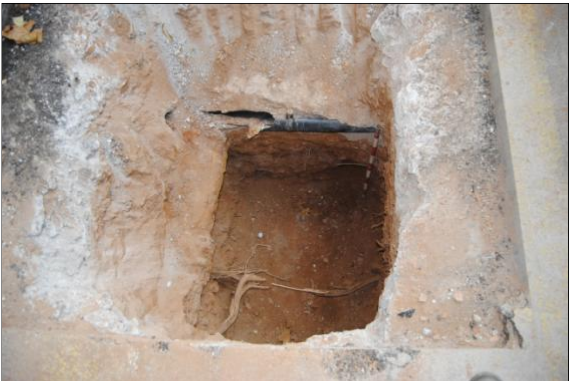
Figura 62. Cala 18. Presència de dos serveis que han remogut els estrats.
