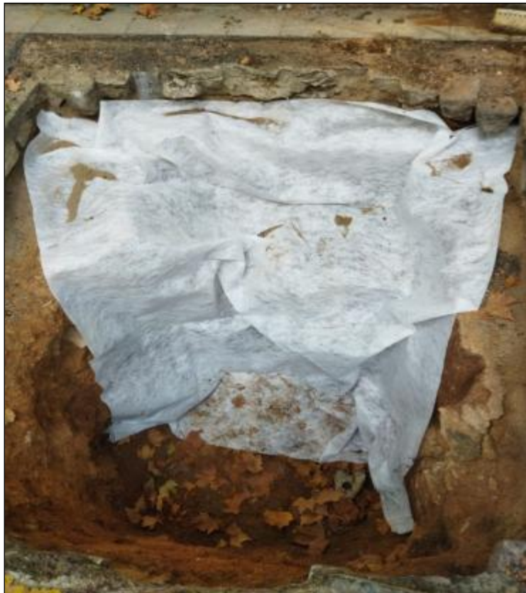
Figura 38. M1 i M2 coberts amb geotèxtil per tornar a omplir la cala amb sauló.
