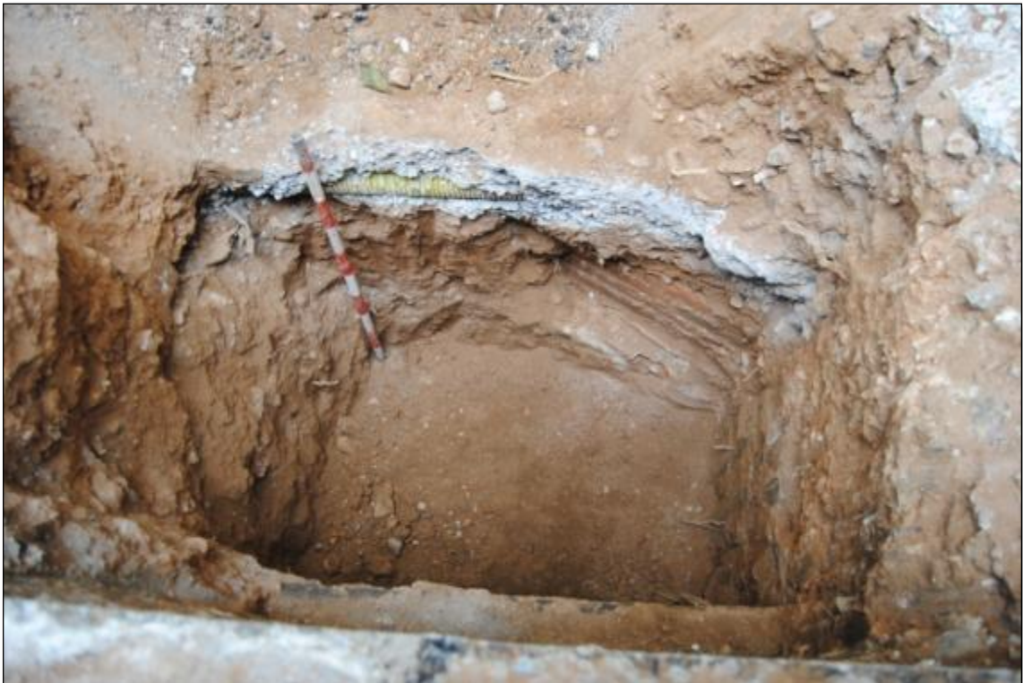
Figura 48. Cala 7. S'ha documentat un mur de maons amb un servei formigonat just a sobre. Segurament sigui un antic col·lector.
