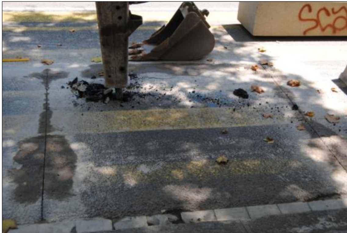
Figura 2. Seguidament es pica l'asfalt amb el martell de la màquina.
