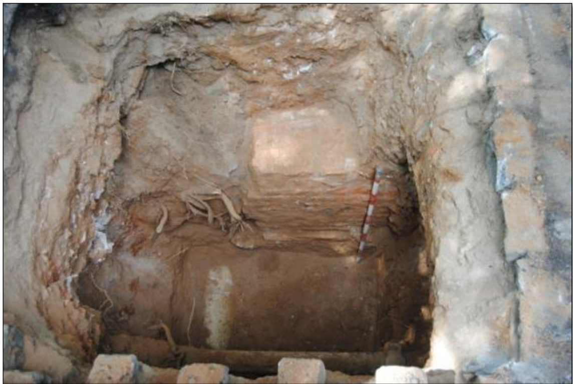
Figura 54. Cala 44. Vista zenital on s'observa l'estructura retallada i els serveis.
